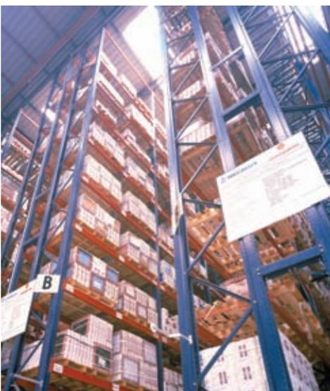
El almacén autoportado constituye la solución más acertada para el almacenaje en gran altura, ya que está concebido para que los racks formen un grupo compacto junto con las cubiertas y los laterales del propio almacén, evitando así la obra civil.
